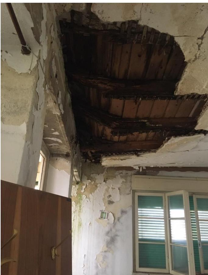
Foto 8. Vista interna: solaio danneggiato
