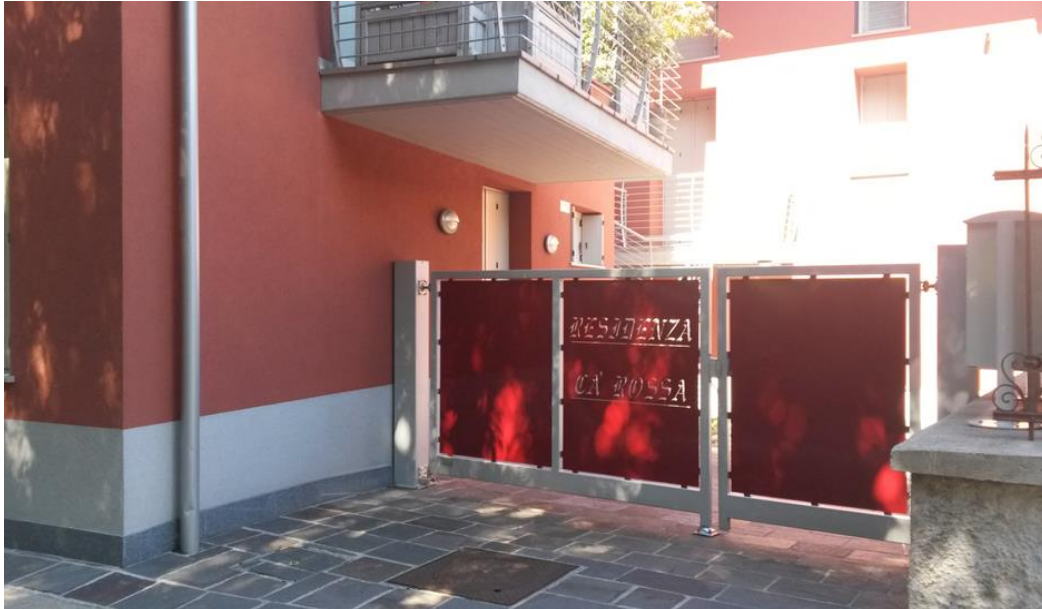
Foto 1: edificio vista ingresso
