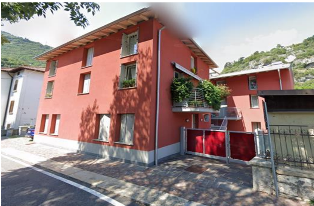
Foto 2: edificio visto da strada
